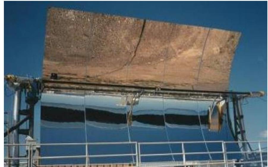
Cilindri parabolici, sali fusi - H<sub>2</sub>O
